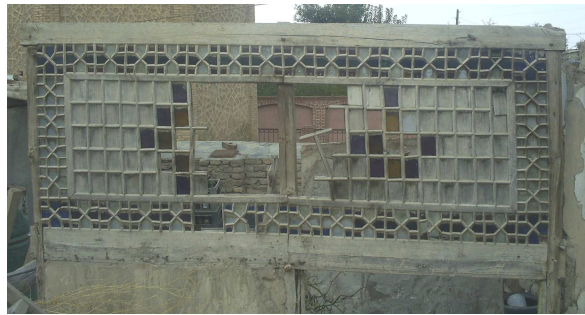
Qapı başlığının şəbəkə bəzəyi. Naxçıvan şəhər Şahab məhəlləsi. XVIII əsr.
